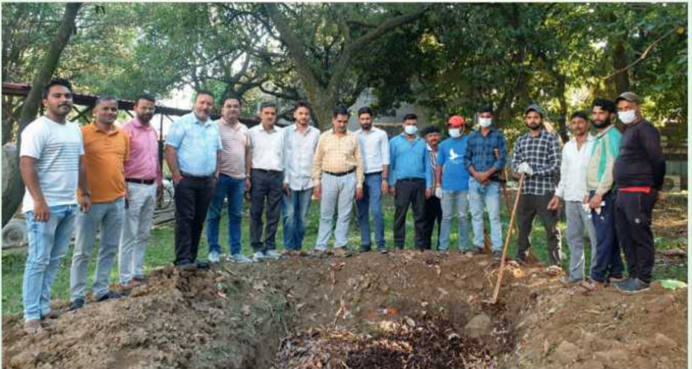
संस्थान के भण्डार अनुभाग के भवन के निकट जैवनिम्नीकरणीय गड़डे का खुदान
