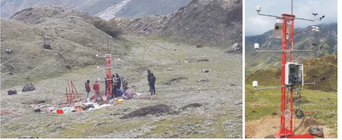
चित्र 9 से 10 : चित्र 9 में ए.डब्लू.एस. स्थापित करते हुए, एवं 10 में अन्ततः स्थापित ए.डब्लू.एस.
